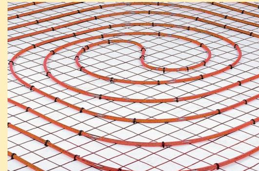
Fußbodenheizung - Kunststoffrohre
