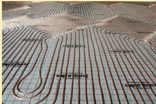
Fußbodenheizung - Kupferrohre
